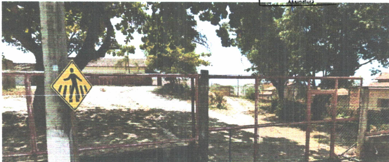
Imagem 02_ Vista Frontal do Imóvel
